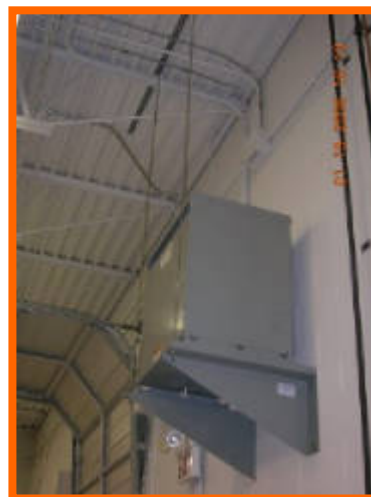
415 Volt - 240 Volt Transformer, wall mounted
